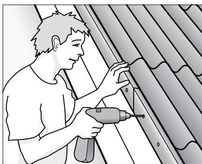
Fastgør løse inddækninger.
