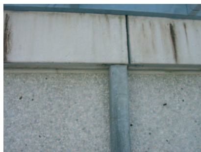
Figur 2. Galvaniseret stolpe med påsvejst plade foroven, som bærer en betondrager.
